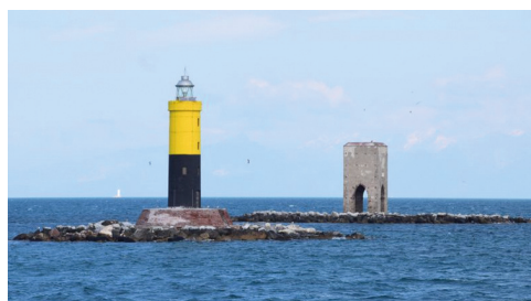
Foto 1 - La Torre della Meloria è stata costruita su uno strato calcarenitico ("panchina") posto poco al di sotto della superficie del mare, circa 7 km ad ovest del porto di Livorno. Nella sua forma a parallelepipedo con base quadrata e altezza di 15 m, presenta la metà inferiore costituita da quattro pilastri uniti da archi ogivali. Sulla facciata esposta a sud è ancora osservabile una lapide, posta durante la riedificazione del 1712, su cui si legge Pro navigantium securitate ad latentes scopulos evitandos.
