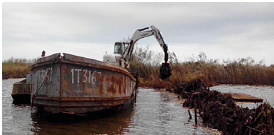
Figura 3: Lavori di costruzione dell'argine per separare il canale del Porto dall'area del "Chiarone": Fase di riempimento con terra di scavo a opera di un escavatore posizionato su chiatta galleggiante.
